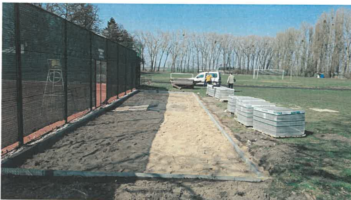
Wykonano opaskę z obrzeży
