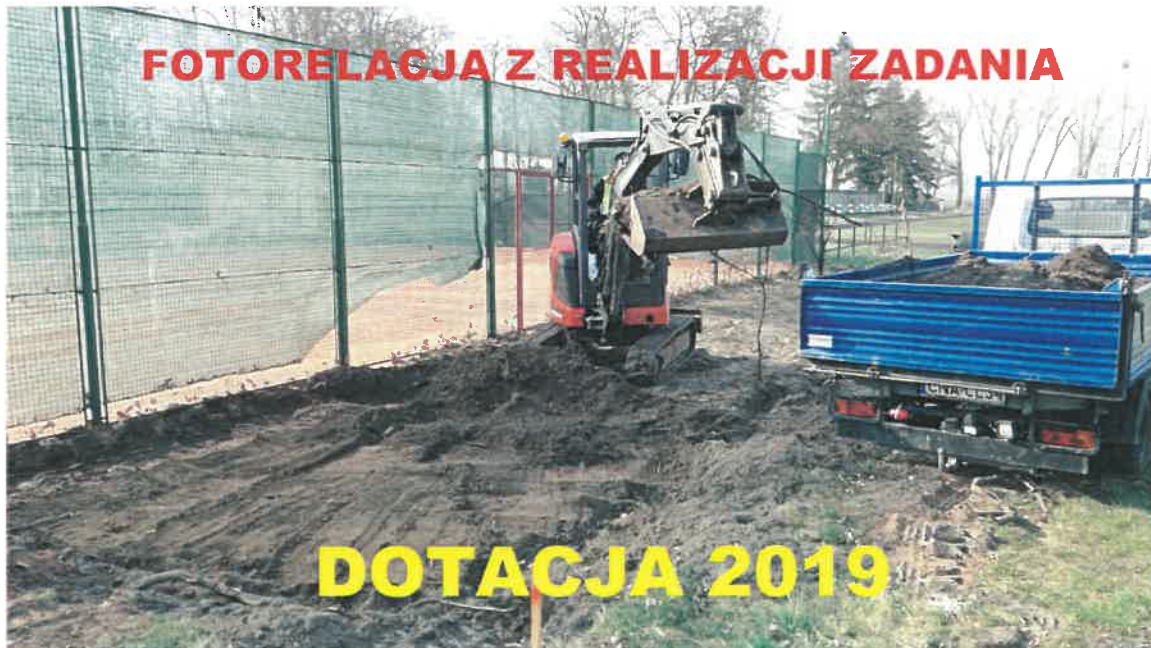
Prace ziemne – usunięcie humusu wzdłuż ogrodzenia kortu.
