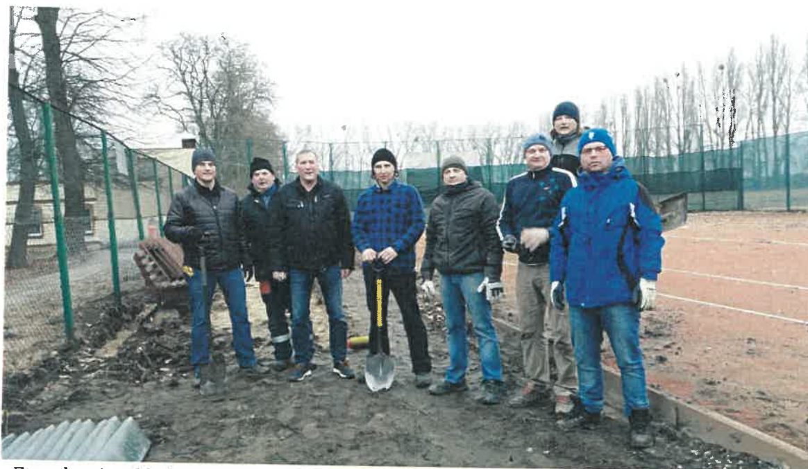
Etap drugi – układamy krawężniki pod kostkę polbrukową – mocna ekipa wolontariuszy.
