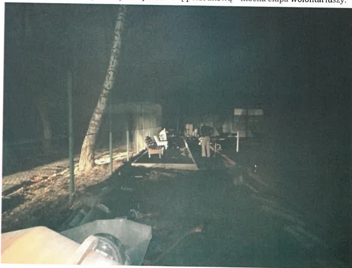
W tym dniu prace trwały do późnych godzin wieczornych przy oświetleniu z naszych aut... Udało się ułożyć krawężniki... Ufff...
