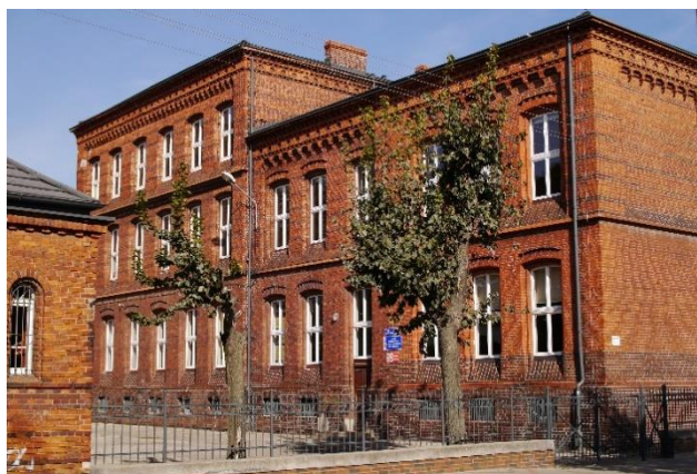
Budynek I Liceum Ogólnokształcącego im. Bolesława Krzywoustego w Nakle nad Notecią
