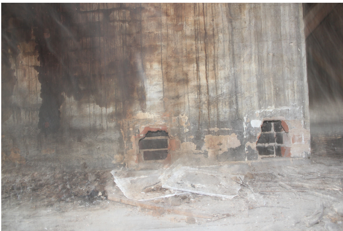
Fot. 16: Uszkodzone wyczystki kominowe
