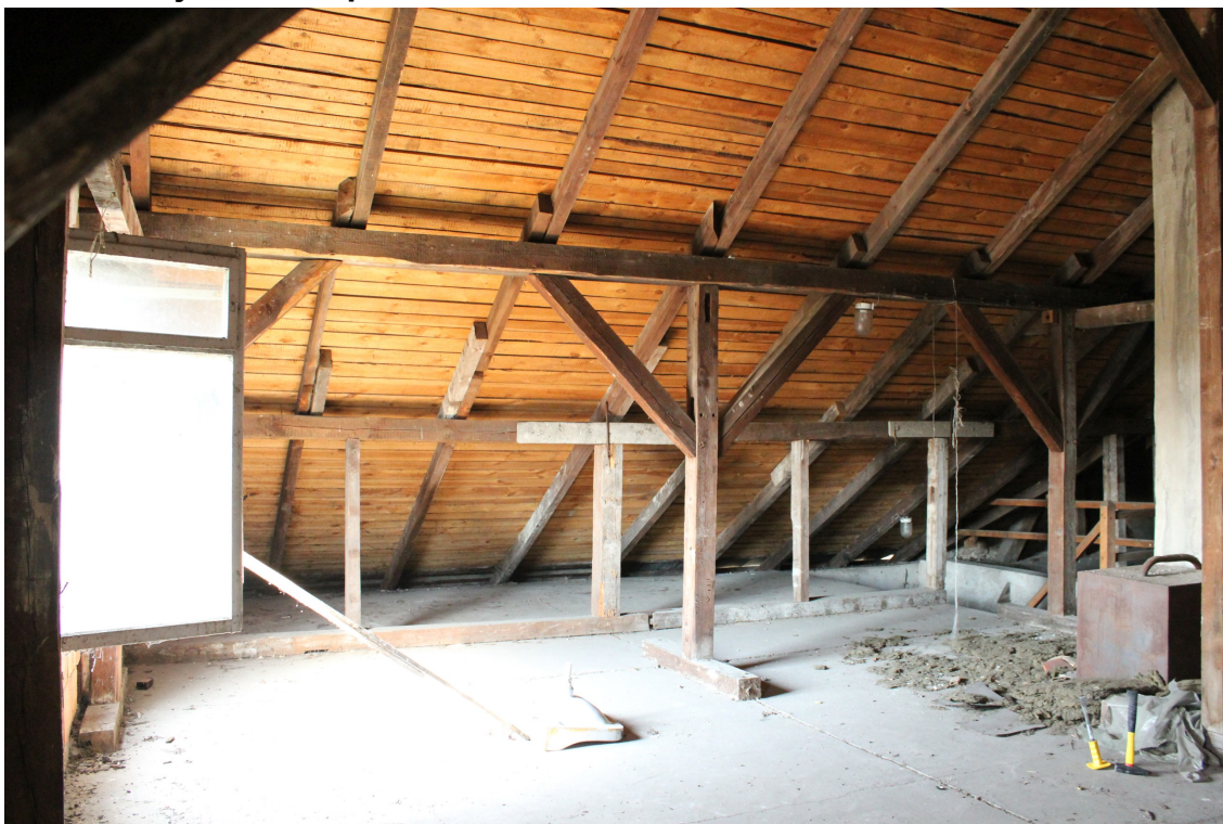
Fot. 5: Konstrukcja dachu nad częścią budynku z salą gimnastyczną – widok na ścianki stolcowe
