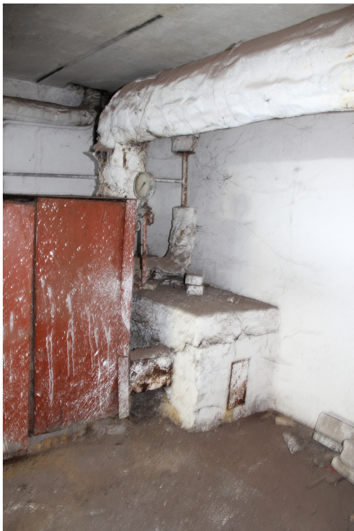
Fot. 31: Kotłownia - piec węglowy
