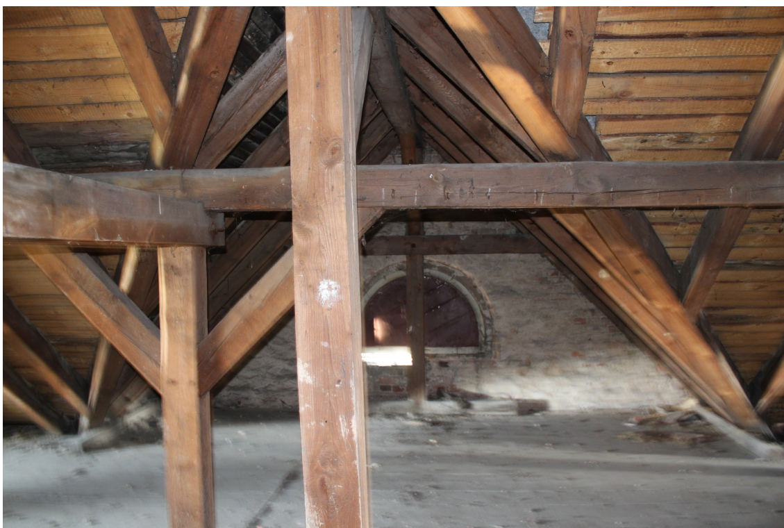
Fot. 14: Konstrukcja lukarny nad pomieszczeniem 2.8
