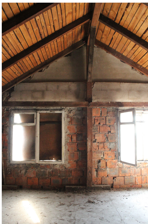
Fot. 6: Konstrukcja dachu nad częścią budynku z salą gimnastyczną - belka kalenicowa
