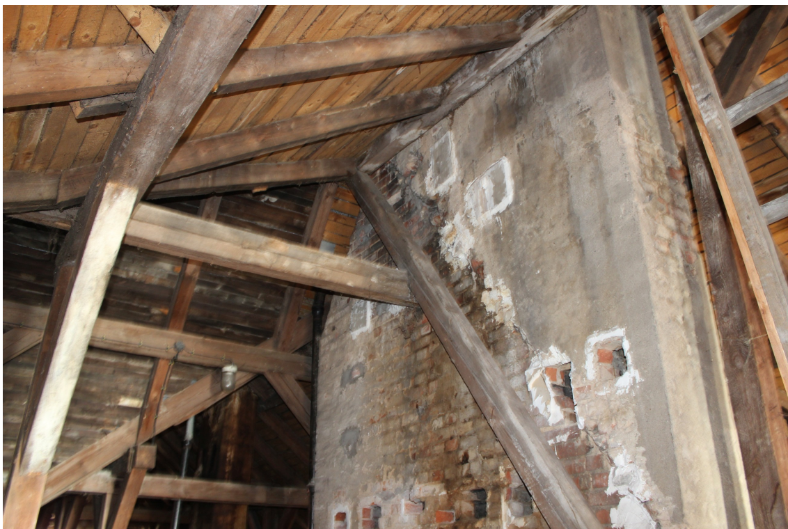
Fot. 15: Kominy dymowe i wentylacyjne - widoczne rozwarstwienie ich ścian
