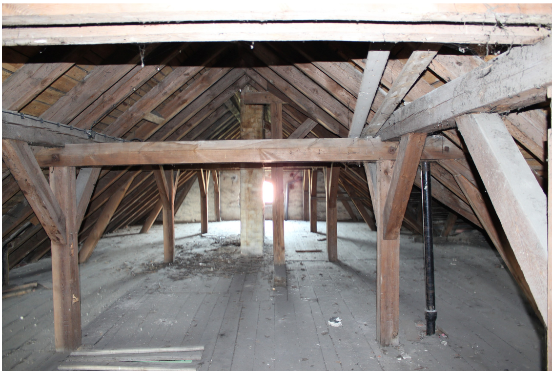
Fot. 11: Konstrukcja dachu mansardowego
