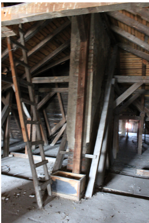
Fot. 9: Układ konstrukcji dachu przy kominie spalinowym
