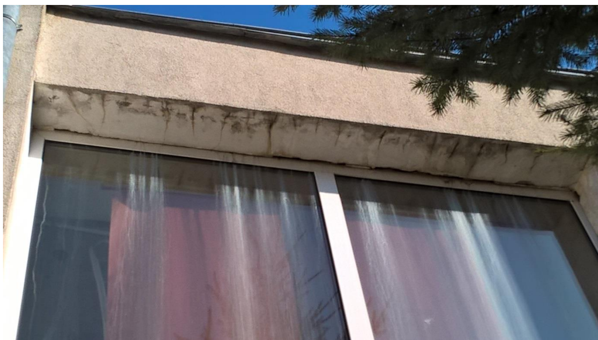
Fot.10. Widok zacieków na oknach sali gimnastycznej
