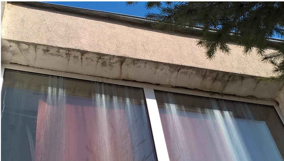
Fot.11. Widok zacieków na oknach sali gimnastycznej
